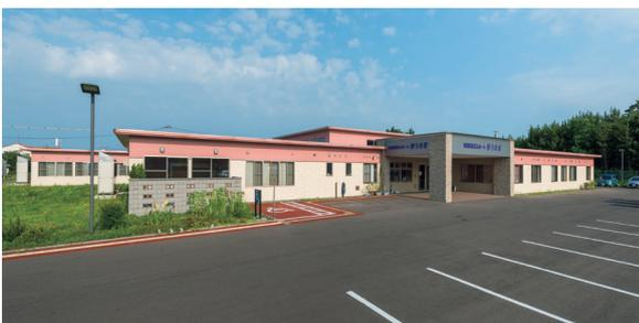
面積1万1429.51㎡の広大な敷地に立っている延床面積3458.12㎡の建物は、鉄骨造陸屋根の平屋建てとなっている
